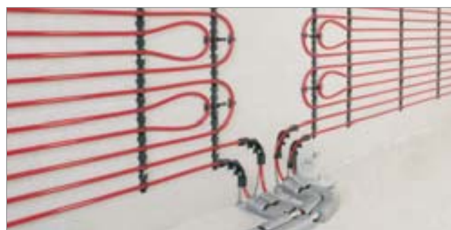
Система настенного отопления/охлаждения («мокрый» способ укладки труб)
