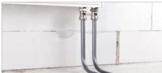
Прямое подключение отопительного прибора трубой RAUTITAN stabil
